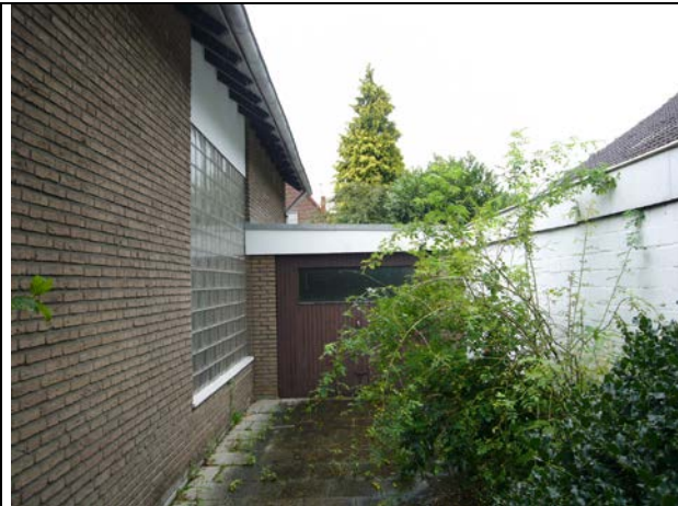
Foto 7: Blick vom Garten auf die Garage
