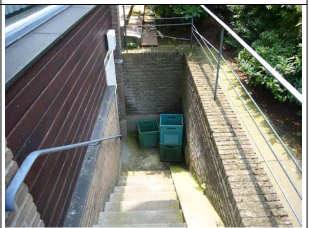
Foto 6: Blick auf die Kelleraußentreppe
